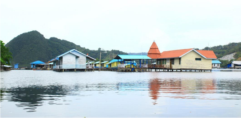
Gambar 2. Rumah-rumah di Kampung Tabaty, di dalam Teluk Youtefa. Bangunan beratap cokelat muda di bagian kanan adalah Puskesmas. Masyarakat membangun jembatan kayu sebagai penghubung antarbangunan.
